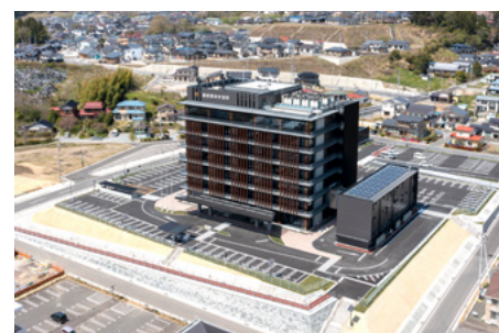
完成した陸前高田市新庁舎
