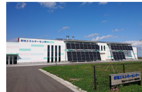
新地エネルギーセンター外観
