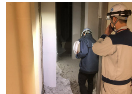
災害復旧の様子
