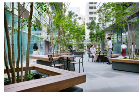
アーバンネット名古屋ネクスタビル 雨水を活用した灌水による植栽 撮影：フォワードストローク
