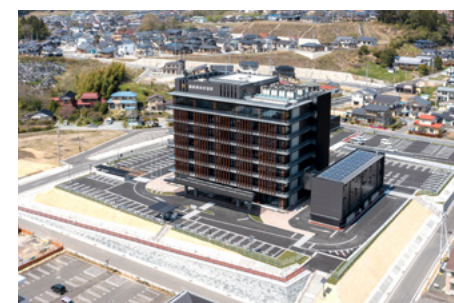
完成した陸前高田市新庁舎
