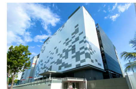
シンガポールでの転換型データセンターの建設例
