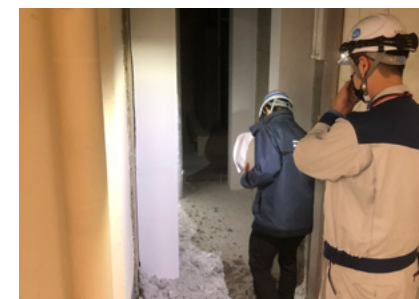
災害復旧の様子
