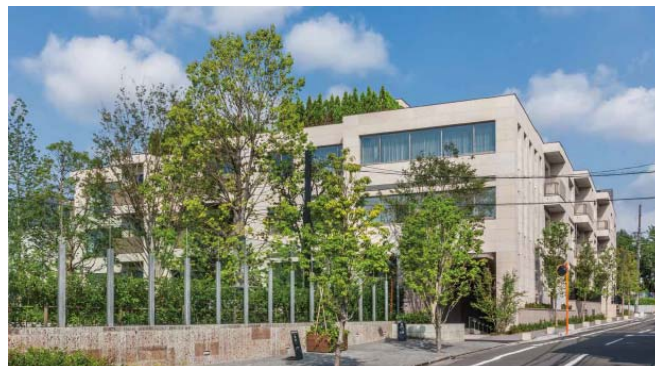
<外観竣工写真>
