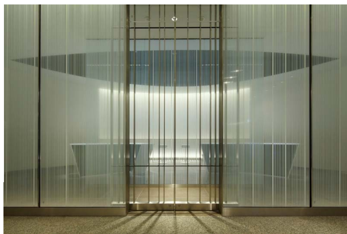
喫煙室の利用時間外用セキュリティ用のルーバー扉をデザイン 換気回数が低下する 20 時以降でも負圧を確保し、周囲に臭いが漏れない
