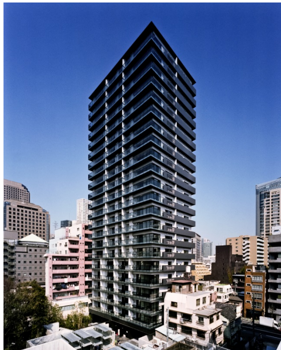
南側外観全景
