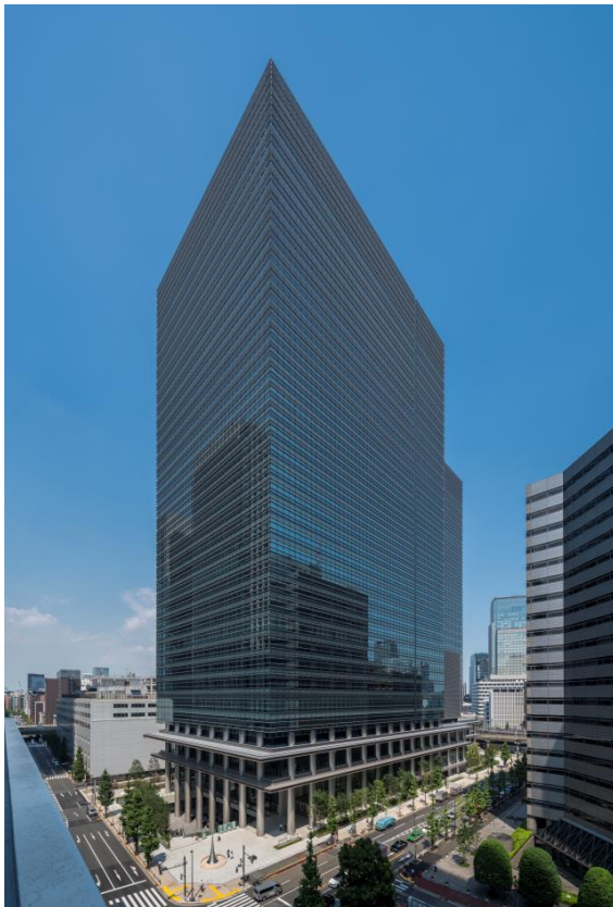
▲ウエストタワー外観（平成30年8月撮影）
