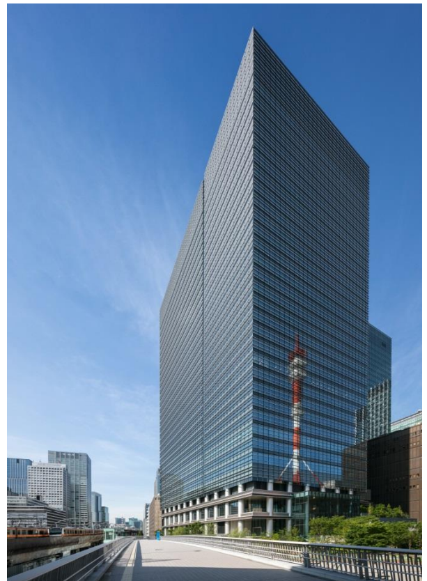
▲イーストタワー外観（平成30年5月撮影）
