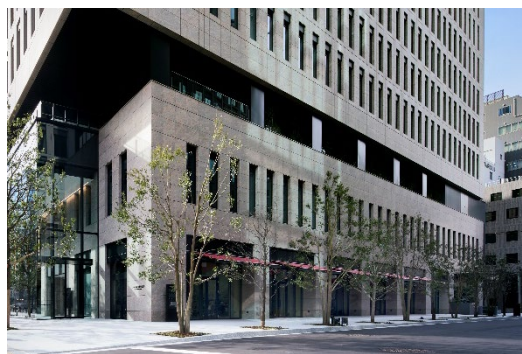
北側 店舗部分外観
