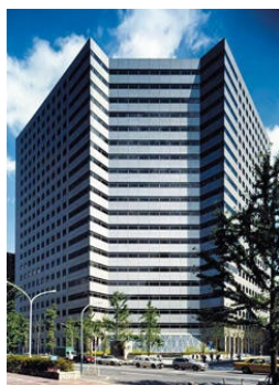
アーバンネット 大手町ビル
