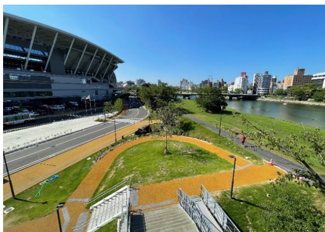
基町環境護岸と商業施設をつなぐ階段とスロープ
