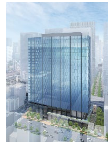
▲大手町ゲートビルディング外観
