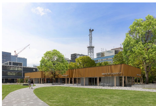
北側から見る全景 中央に植えられたクスノキは建物背後の「県庁の森」から移植
