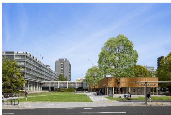
西側から見る全景 正面および左側に建つのが県庁舎（1956 年竣工）
