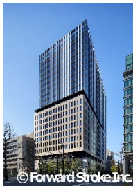
アーバンネット御堂筋ビル (大阪府大阪市)
