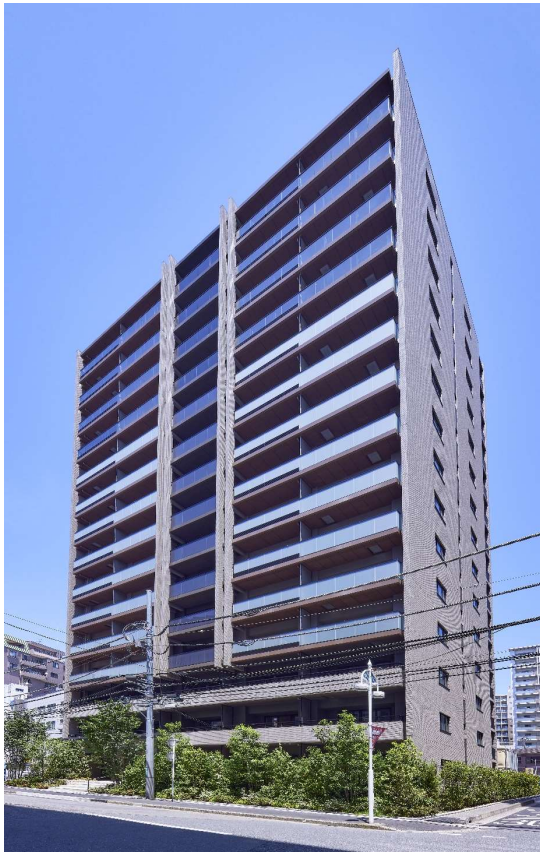
建物外観 -落ち着きのある色調に際立つ水平垂直のライン-
