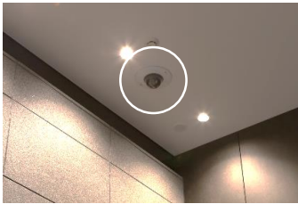
B1階ロビー天井
